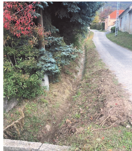
Vízvezető árok kitisztítása
